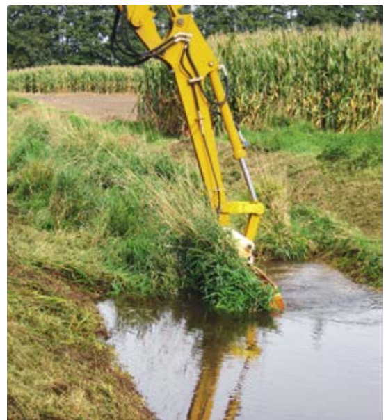
Abb. 2: Der Mähkorb als wichtigstes Arbeitsinstrument kann auch behutsam bis filigran eingesetzt werden, so dass eine naturverträgliche Unterhaltung möglich ist. Links: Belassen eines schmalen Saumes; rechts: Krautung des kompletten Profils (TSCHÖPE 2010–2012)
