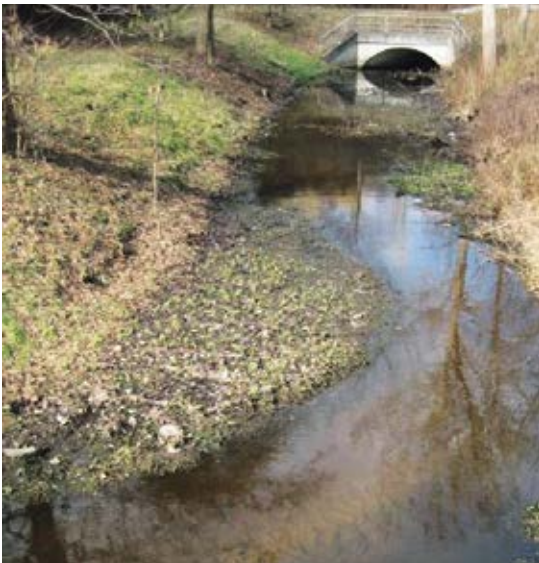
Abb. 4: Entwicklung des Fließgewässercharakters durch Verengung des Niedrigwasser-Profiles und Erzeugung von Schattendruck
