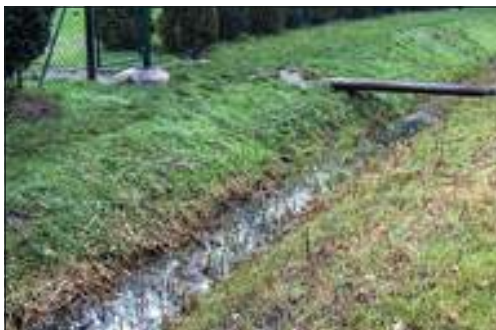
Hier ist der Bewuchs auf der Sohle auf beiden Seiten nicht ausreichend entfernt.
