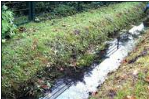
Ein vorbildlicher Graben mit Schauweg links
